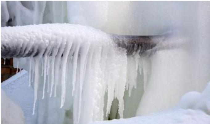
**В**о избежание аварий и ненужных расходов, изолируйте водопроводные вводы и водомеры специальными материалами, оставляя открытым только табло для считывания данных о потреблении воды. Кроме того, крышка колодца со счётчиком должна закрываться максимально плотно.
