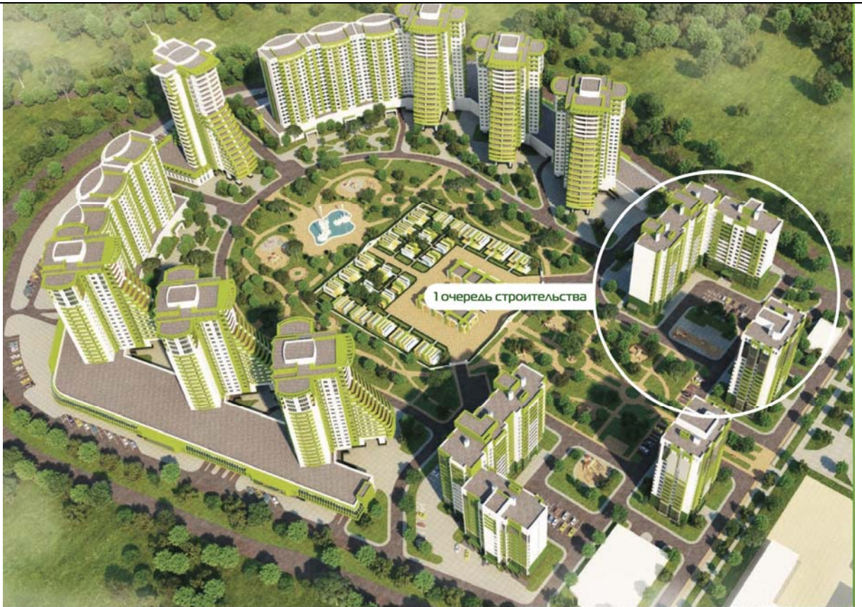
Новострой в Калуге - установка системы учета БАЛАНС
